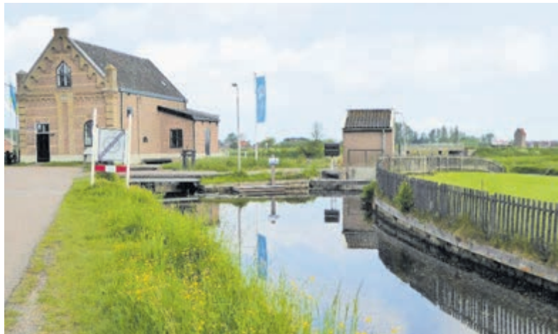
Gemaal 1879 aan de Fielkersweg 4 in Akersloot. Foto: Léon Klein Schiphorst
