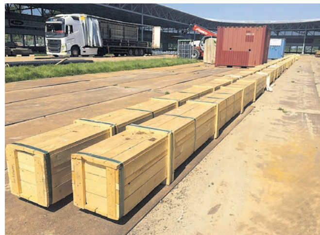
In deze houten kisten zitten de 18 meter lange baanpijpen waarmee de ijsbaan straks gekoeld wordt
