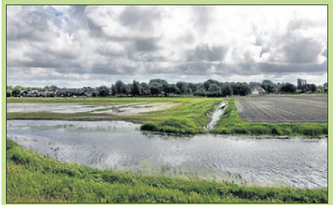
Waterberging langs de Zeeweg te Castricum, onderdeel van het groter waterbergingsproject Schulpvaart.
